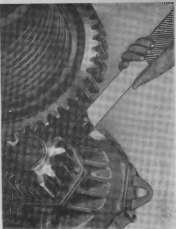
Рис. 47. Смазка наружного зацепления стреловой защелки
