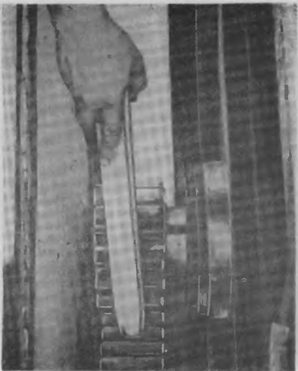
Рис. 51. Смазка белюковой шестерни и зубчатого венца среднего порога
